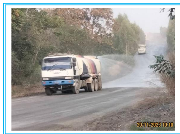
รูปที่ 2.8-1 ฉีดพรมน้ำตามเส้นทางขนส่งแร่
