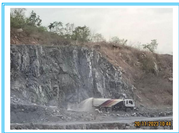
รูปที่ 2.8-1 ฉีดพรมน้ำตามเส้นทางขนส่งแร่
