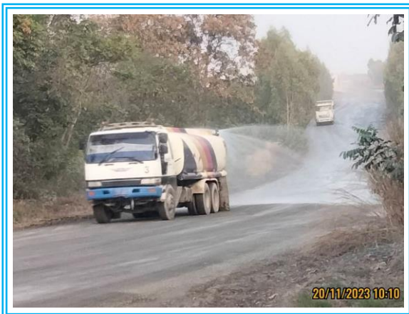
รูปที่ 3-12 การฉีดพรมน้ำเส้นทางขนส่งแร่จากหน้าเหมืองถึงโรงโม่หิน
